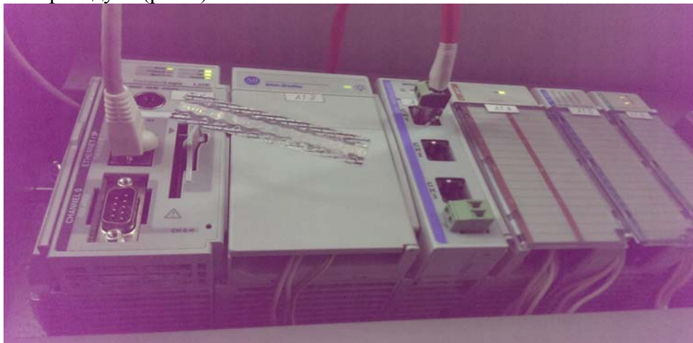
Рис. 2. Место опломбирования модуля измерительного.
